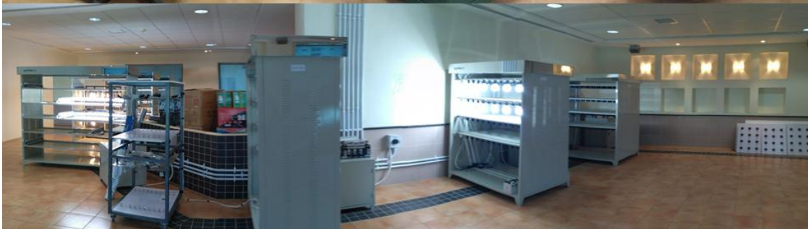
مختبر كفاءة الطاقة والذي يعتبر أحد أحدث المختبرات في مجاله على مستوى المنطقة
